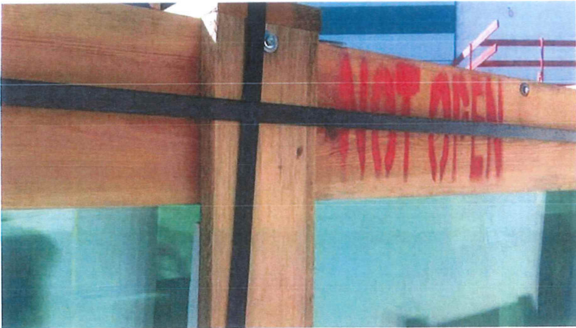
Photo 2 = Côté à ne pas ouvrir (vu sur une caisse en stock sur le chantier)
