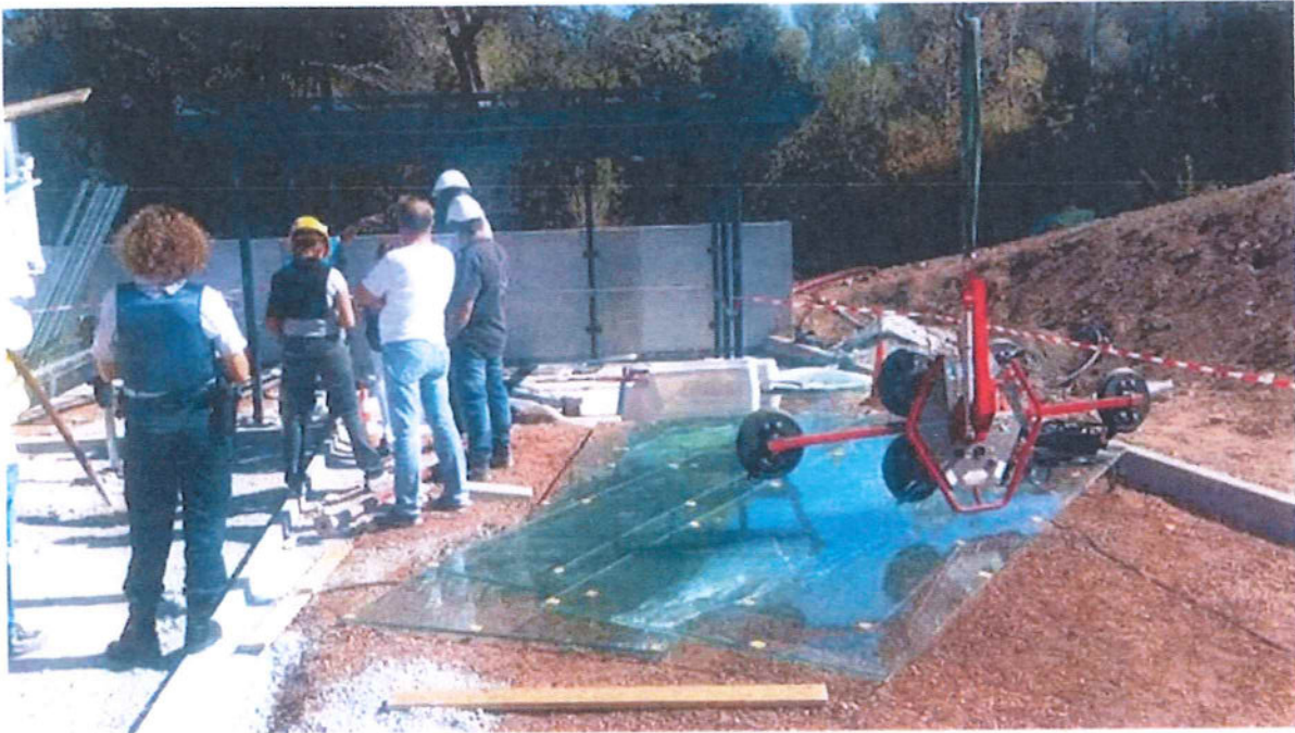
Photo 5 : Déchargement des premiers vitrages pour soulager la victime
