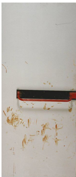
Porte de la chaufferie
